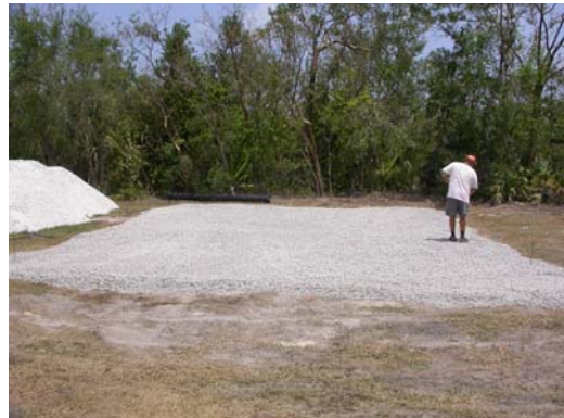
B. Granite drainage layer (6").
